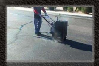
Работы по заполнению швов и трещин в асфальтобетонном покрытии следует выполнять после обработки асфальта APT-78.
