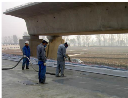
Обработка опор моста ELASTUFF
