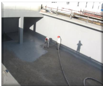
Нанесение материала ELASTUFF в очистных сооружениях
