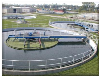
ELASTUFF на водоочистных сооружениях
